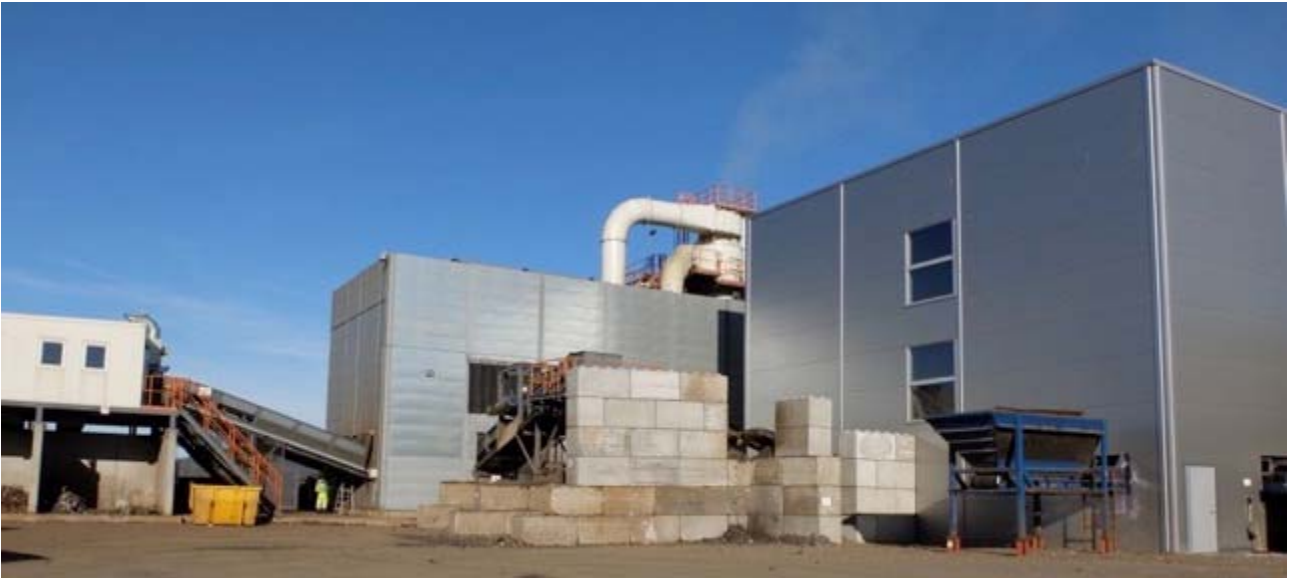
Figur 5: Shredderanlegg for neddeling og separering av kompleksjern. Foto: Fredrik Gaustad
